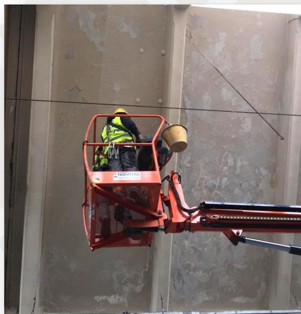
I sistemi antisfondellamento **OLYMPUS SAFE** grazie alla loro semplicità e velocità di posa in opera, consentono di realizzare interventi di messa in sicurezza di interi opifici industriali in tempi molto brevi e senza determinare prolungati e dannosi fermi macchina.
