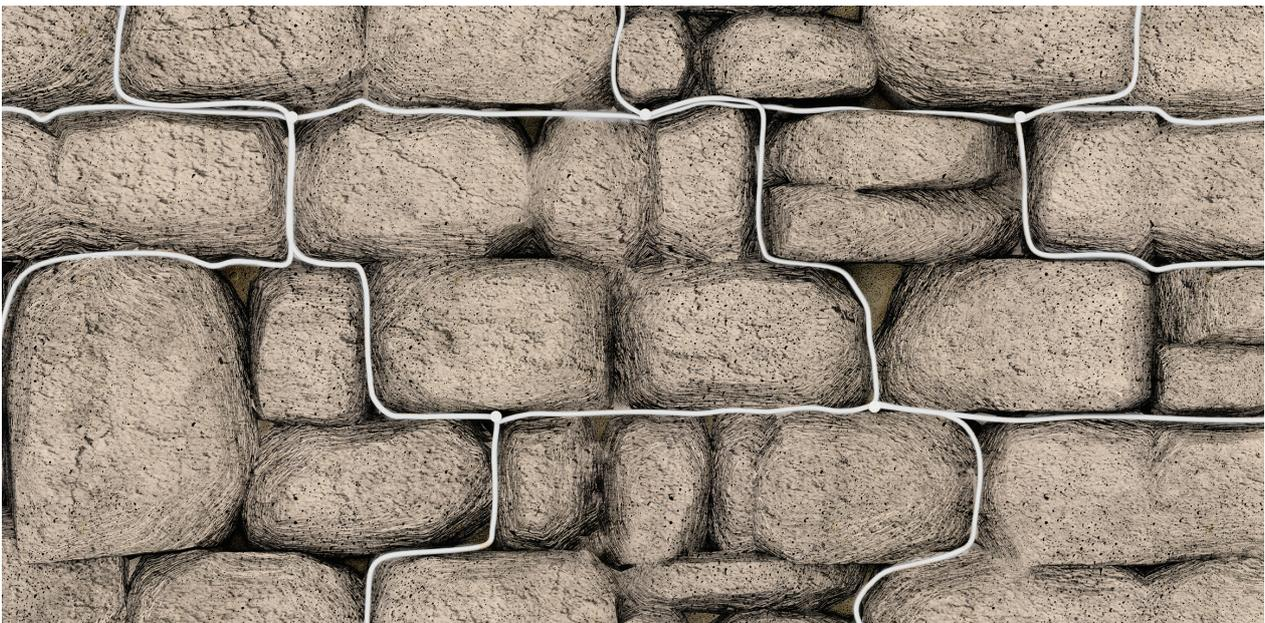
Esta técnica puede utilizarse tanto para reforzar un solo panel de mampostería como para reforzar una estructura interna y creando también una conexión eficaz entre la mampostería transversal gracias a la continuidad de los cables de acero reforzando las juntas del mortero.
