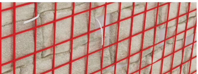
Los sistemas FRCM de la línea OLYMPUS STONE se ajustan a las *Directrices de identificación pruebas de calificación y aceptación de la matriz inorgánica de materiales compuestos reforzados con fibra con matriz inorgánica (FRCM) para su uso en la consolidación estructural de edificios existentes* emitidos por el Servicio Técnico Central del Consejo Superior de Obras Públicas de Italia en diciembre de 2018.
