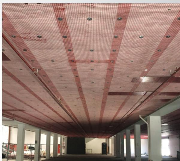
se pur non direttamente collegati alla capacità portante, possono essere causa di perdite in termini economici e di vite umane. Questi elementi sono stati la fonte di crolli che hanno portato all'inagibilità di edifici ed a perdite e rischi per la vita umana. L'assenza di fenomeni di ossidazione, inoltre, garantisce un'elevata durabilità nel tempo di questi sistemi, eliminando le criticità tipiche degli interventi tradizionali.
