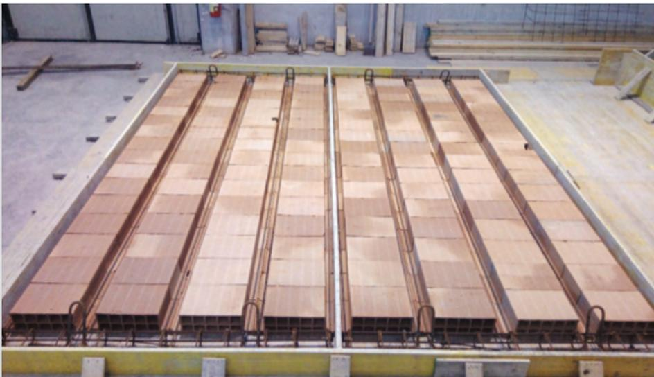
Preparazione del solaio laterocemento
