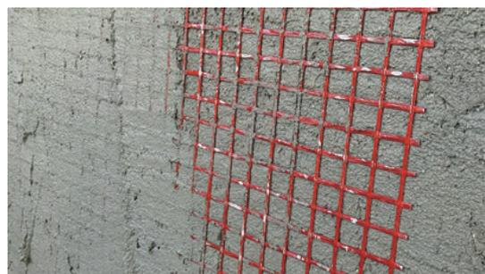
I sistemi FRCM della linea OLYMPUS STONE sono certificati CVT ai sensi della *Linea Guida per la identificazione, la qualificazione ed il controllo di accettazione di compositi fibrorinforzati a matrice inorganica (FRCM) da utilizzarsi per il consolidamento strutturale di costruzioni esistenti* emanata dal Servizio Tecnico Centrale del Consiglio Superiore dei Lavori Pubblici nel mese di Dicembre 2018.
