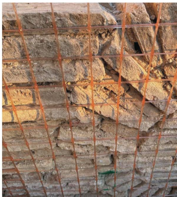
Con i nuovi sistemi di intonaco armato CRM della linea **Olympus STONE** è possibile realizzare interventi compatibili con le murature e che non presentano particolari criticità. Per definizione un sistema CRM ha uno spessore compreso tra 30 e 50 mm al netto dell'eventuale livellamento del supporto.
