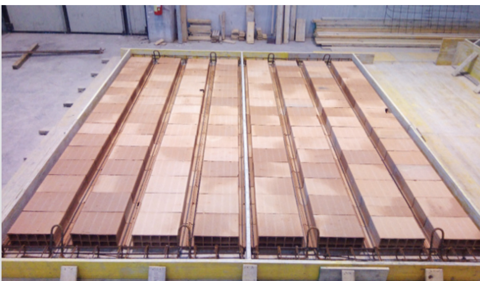
Preparazione del solaio laterocemento
